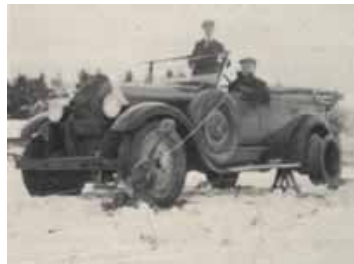
Vanhasta Cadillacista rakennettiin vintturi 1937
